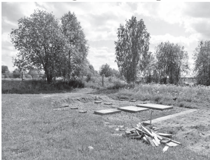
Подготовка площадки для установки тренажеров. Фото: Сергей Юдин
