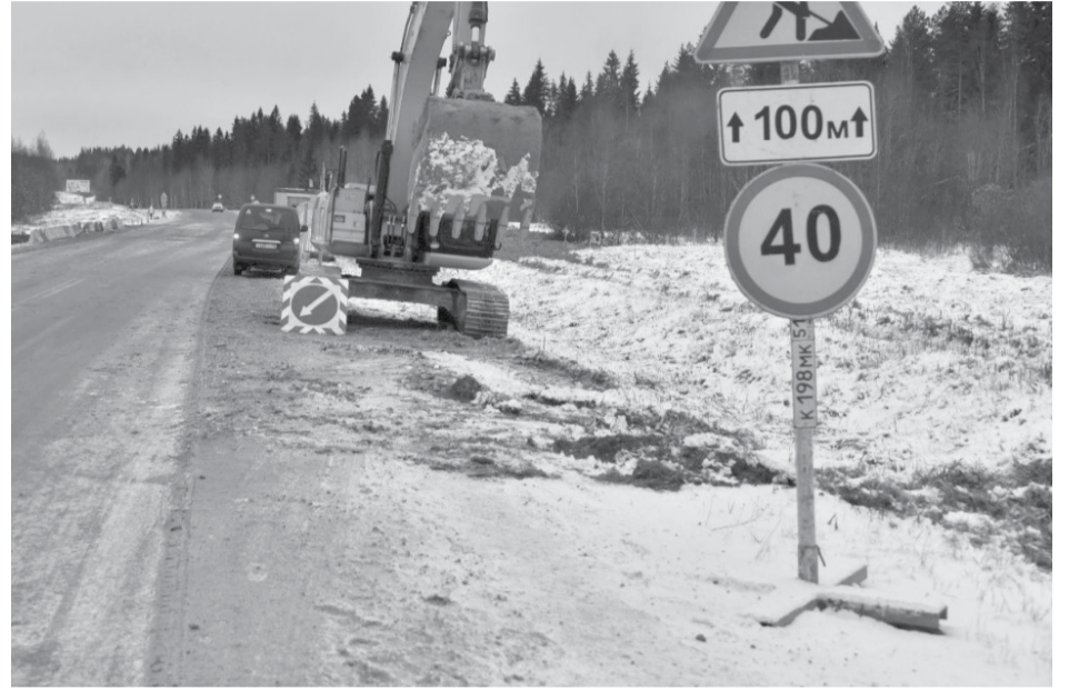
Ремонт дороги к Вятсиля. Фото ИА «Республика»/Николая Смирнова
