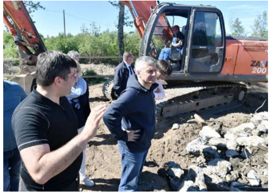
На месте строительства канализационно-очистных сооружений в Ладве
