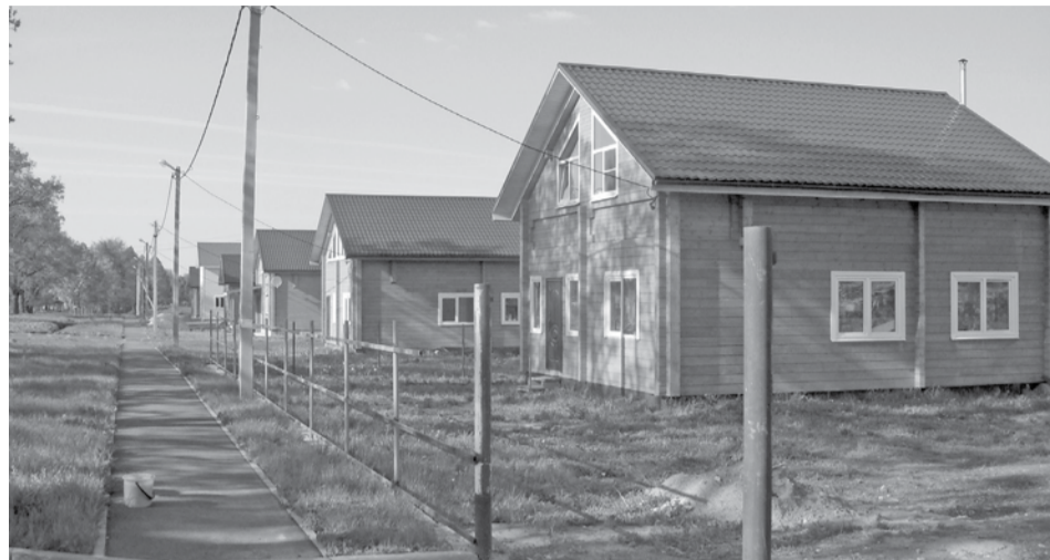
Пример строительства жилья на подготовленной площадке. Фото пресс-службы Правительства РК
