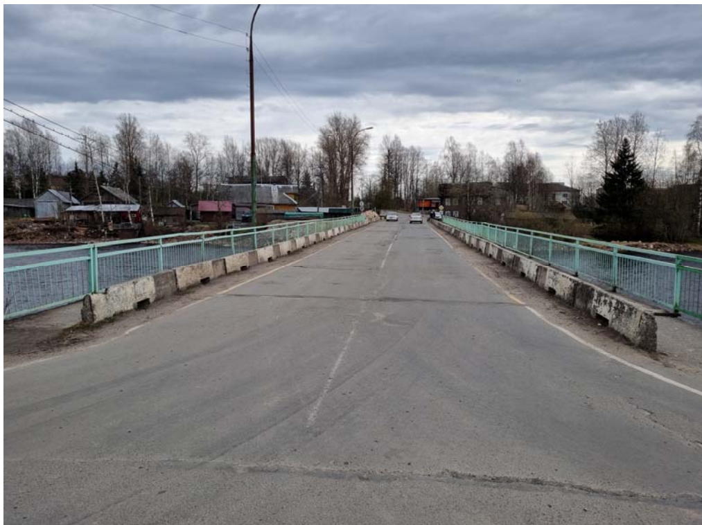
Вид на мост в начале трассы.
