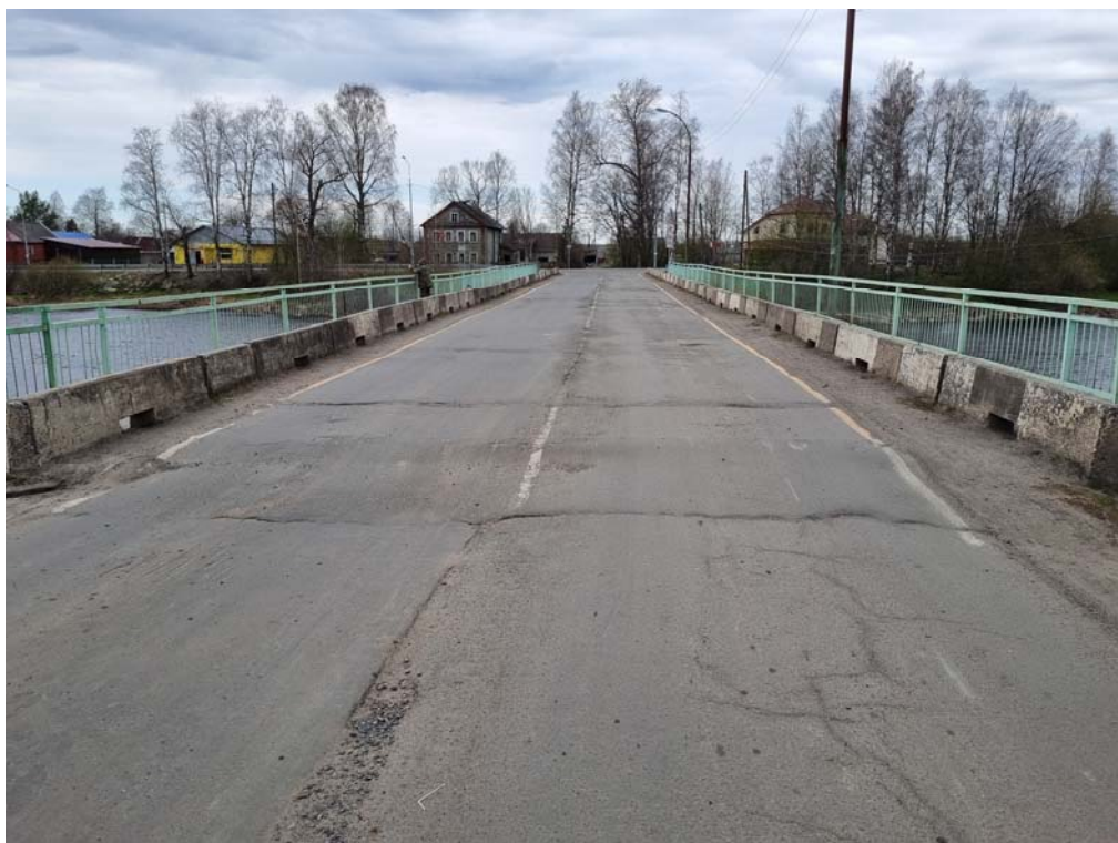
Вид на конец моста.
